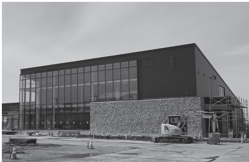
建設中のアウトドア拠点施設（4月11日 撮影）
